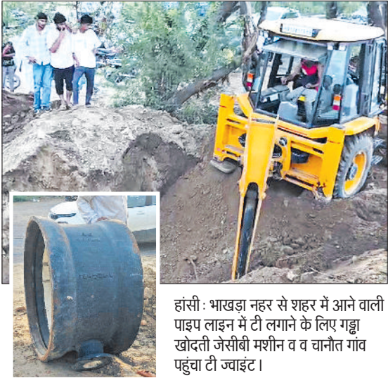
हांसी : भाखड़ा नहर से शहर में आने वाली पाइप लाइन में टी लगाने के लिए गड्ढा खोदती जेसीबी मशीन व चानौत गांव पहुंची टी ज्वाइट।
